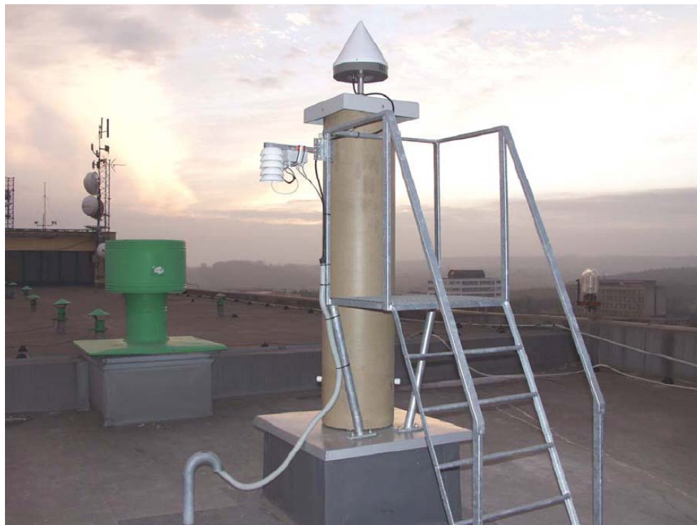
Obr. V.4.10 Ukázka referenční stanice GPS/GLONASS, vybudované na střeše hlavní budovy porubského areálu VŠB-TU Ostrava. Na obrázku je patrný pilíř s anténou a meteorologická čidla.
